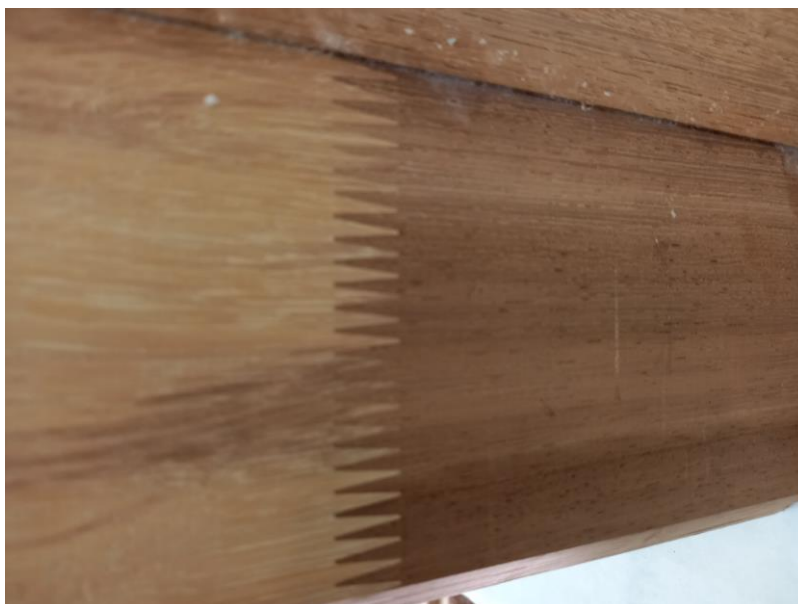
Εικ. 17. Κοντινή εμφάνιση μιας δακτυλοειδούς σύνδεσης στην ξύλινη δοκό.
